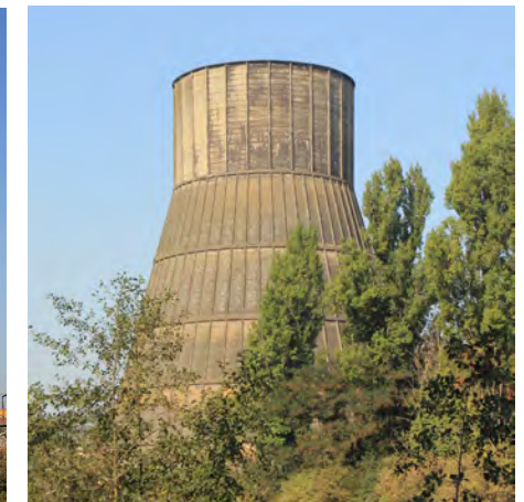
tour de refroidissement
