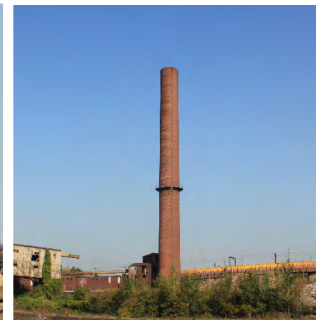
cheminée sur le site Porte Ouest
